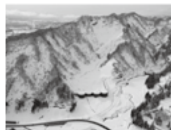
本えん堤完成状況▶P.29
