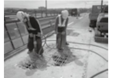
床版破損箇所はつり作業▶P.35
